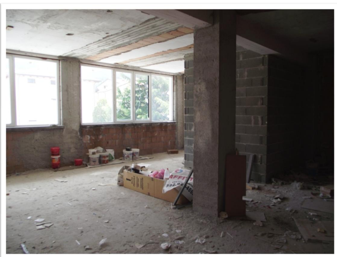
Foto 26 – Lotto E, piano primo, locale allo stato grezzo
