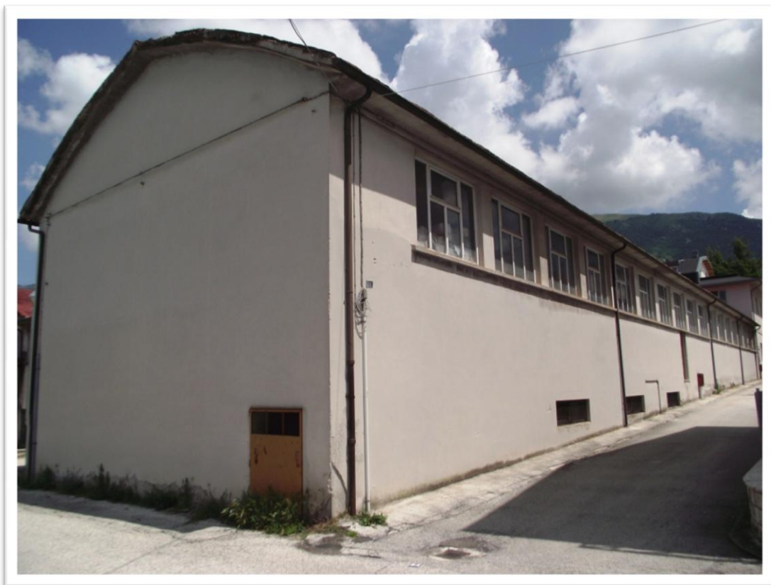
Foto 3 – esterno edificio, prospetto SUD
