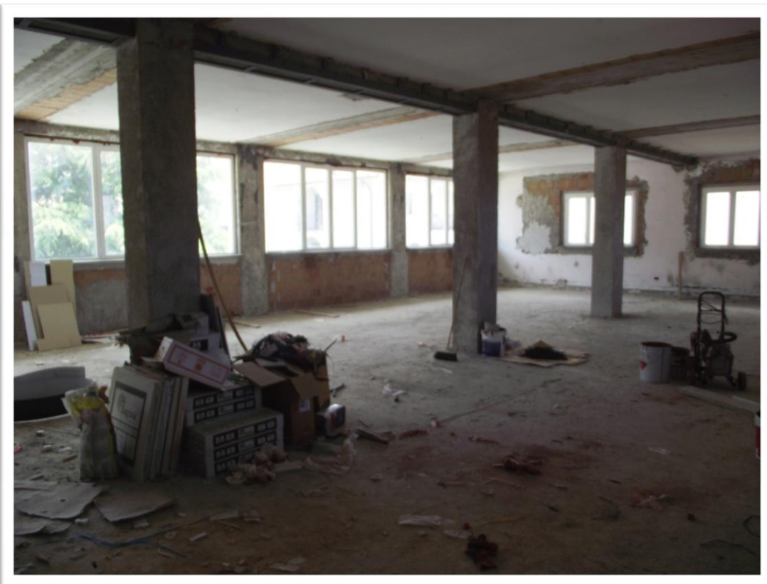
Foto 25 – Lotto D, piano primo, locale allo stato grezzo
