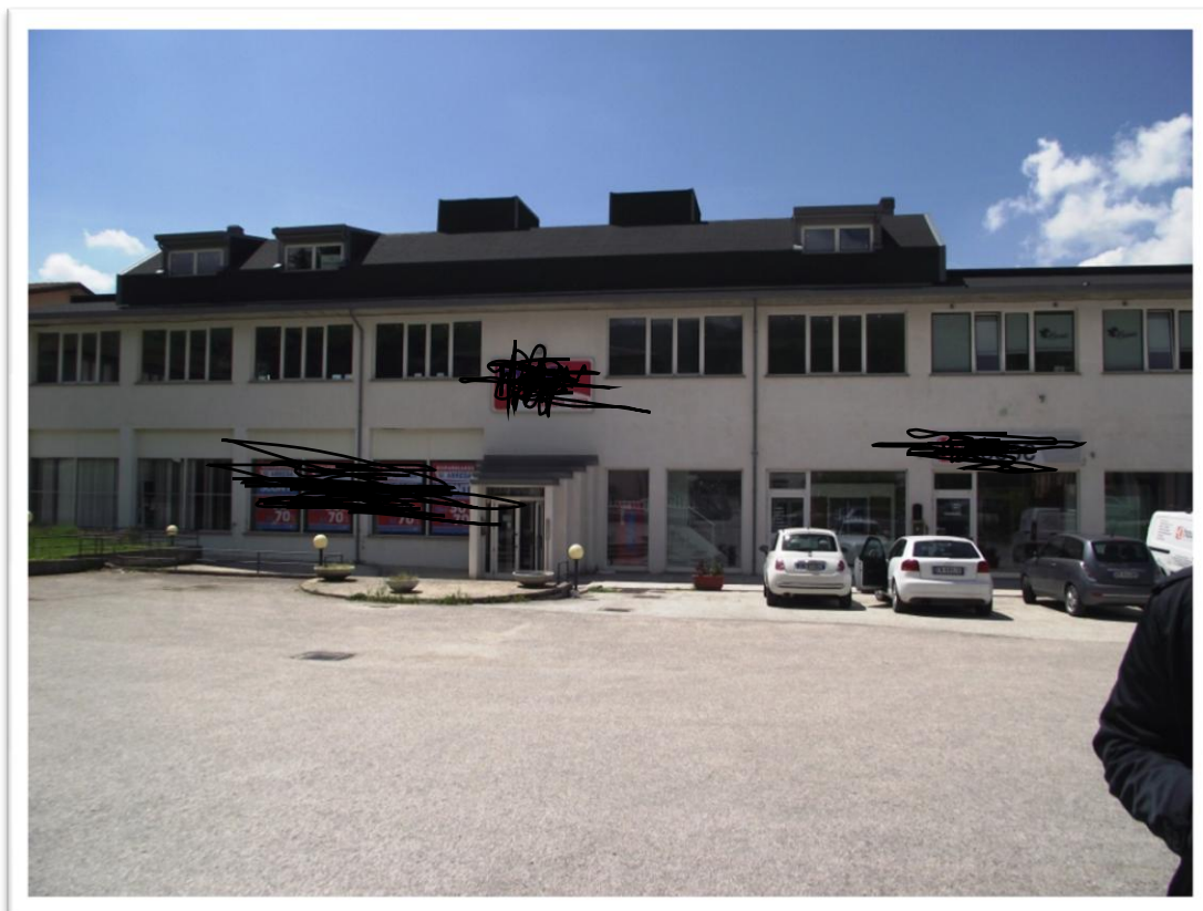
Foto 1 – esterno edificio, prospetto EST
