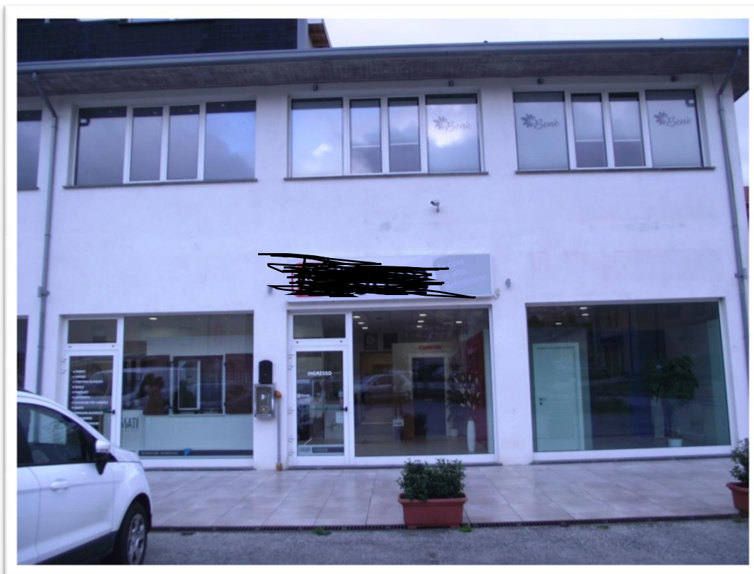
Foto 29 – Lotto G, piano terra, esterno locale commerciale
