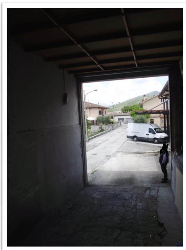
Foto 18 – Lotto B, accesso mezzi pesanti per carico/scarico
