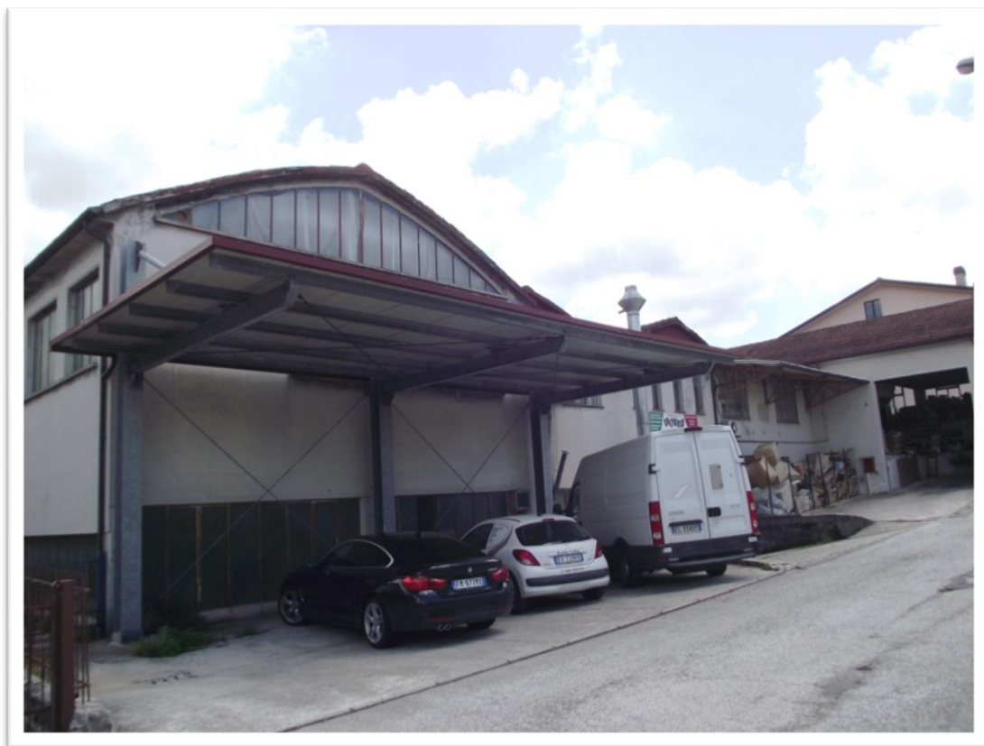
Foto 4 – esterno edificio, prospetto OVEST
